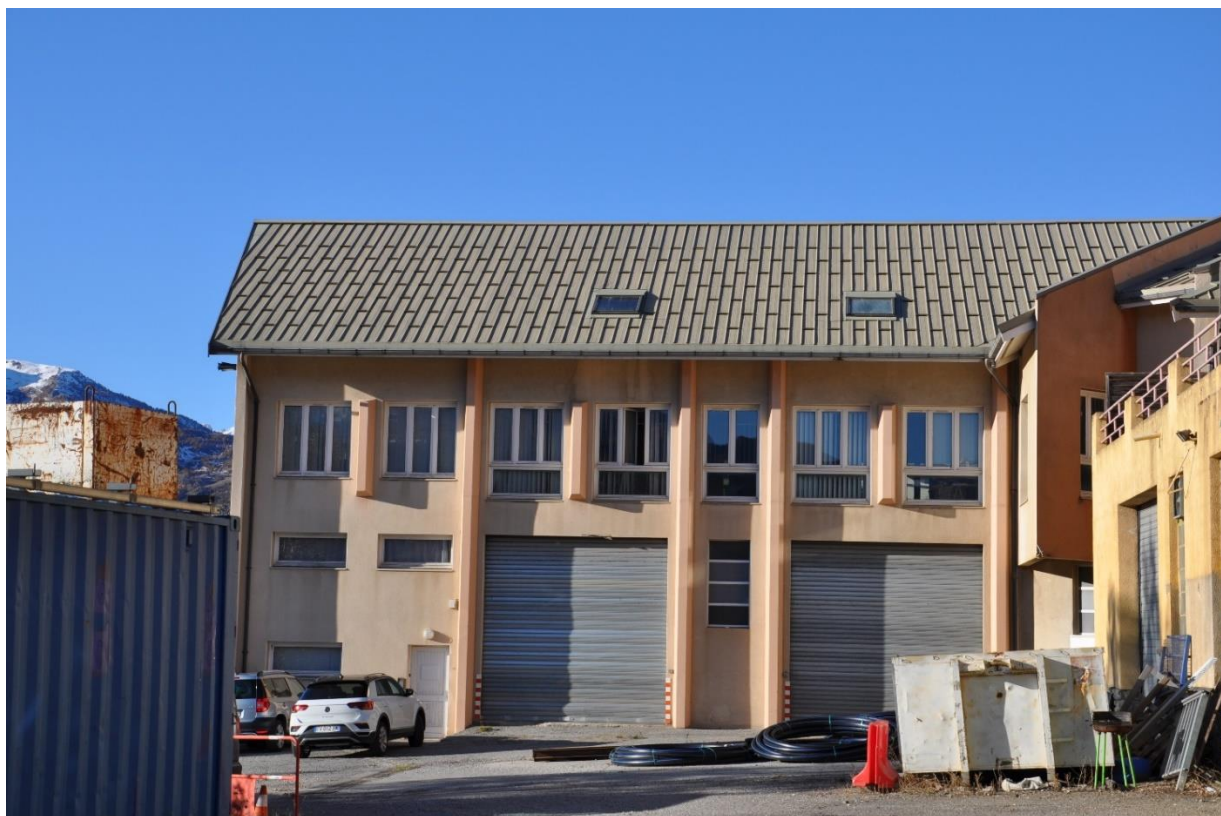
Locaux Queyras Saint Crepin
