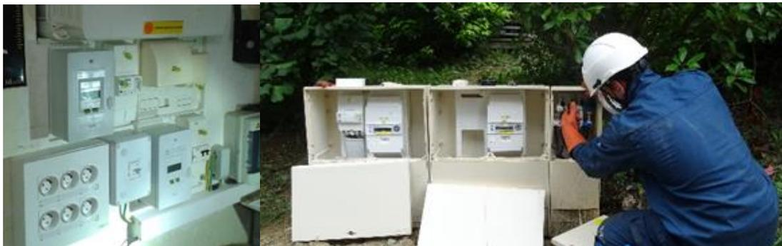
Figure 21 : Installation des compteurs communicants sur Les Haies – Source Enedis
