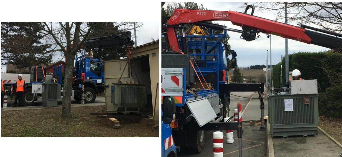
Figure 27 : Installation du transformateur avec régleur en charge dans le poste "Ecole" – Source Enedis
