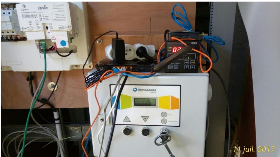
Figure 28 : Connexion entre le concentrateur et le transformateur avec régleur en charge - Source ATOS
