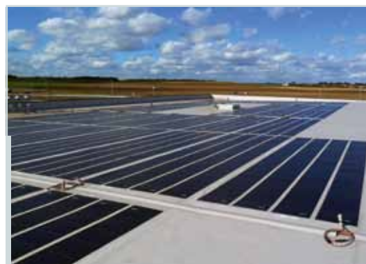
Installation sur le toit d'un bâtiment industriel - panneaux souples
