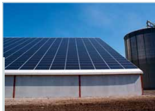
Installation sur le toit d'un bâtiment agricole
