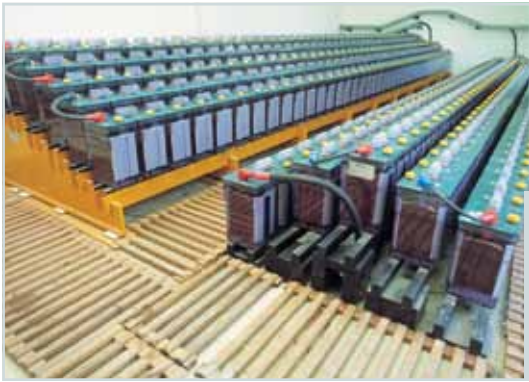
Batteries dans un local spécialement adapté
