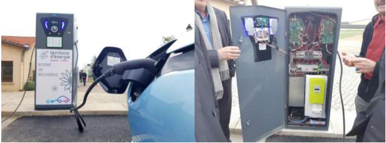
Figure 28 : Photos de la borne de recharge installée sur Les Haies - Source Enedis
