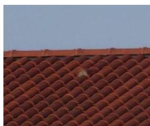
Certains toits disposent de tuiles chatières qui servent à ventiler la toiture. Il est aisé de les déplacer. On peut alors les positionner au-dessus du champ PV pour faciliter l'évacuation de la chaleur.
