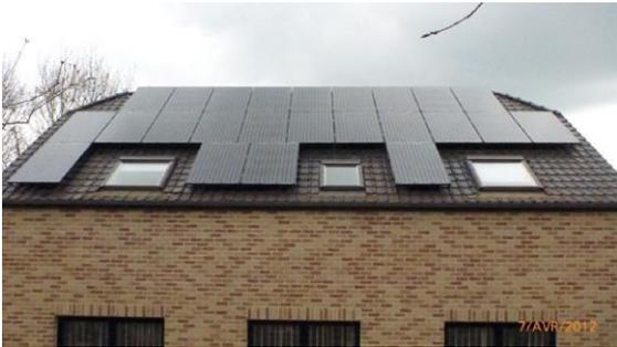
Les panneaux font généralement 1m de large par 1,7m voire 2m de long. La surface disponible n'est donc pas le seul critère. Il faut pouvoir placer les panneaux entre deux "obstacles" ou un obstacle et un bord de toiture. L'exemple ci-contre est extrême et ne serait pas toujours accepté par les services d'urbanisme.
